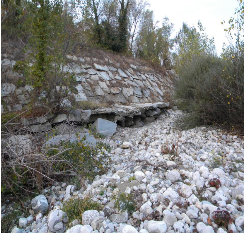
Muro di contenimento della ciclabile in fase di magra
