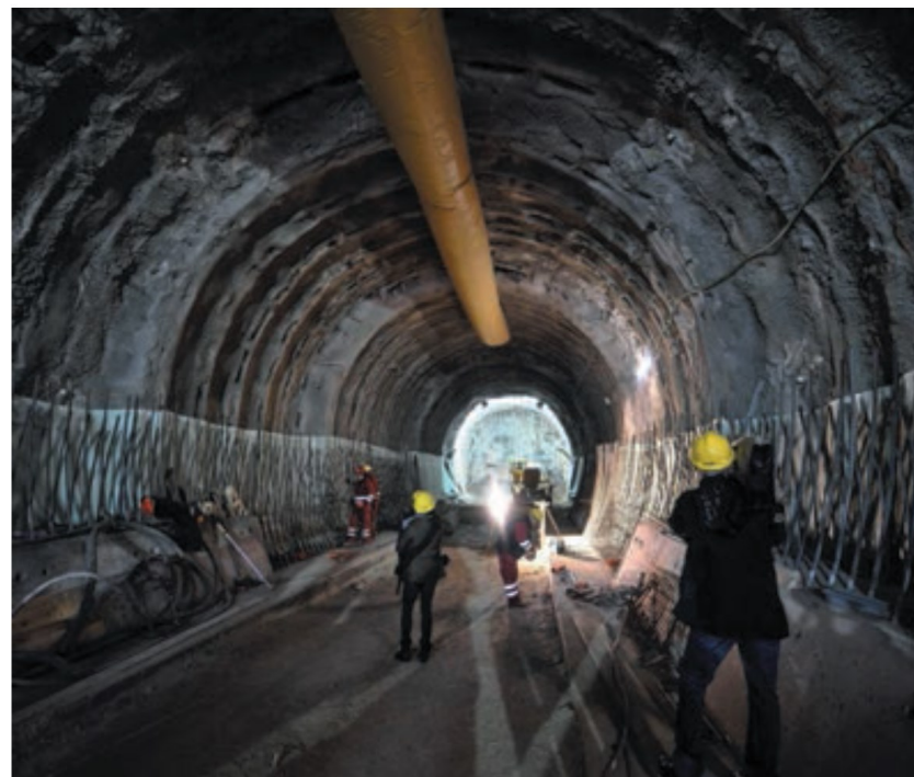
NUOVA TRATTA FERROVIARIA Via libera ai lavori definitivi della sezione transfrontaliera
