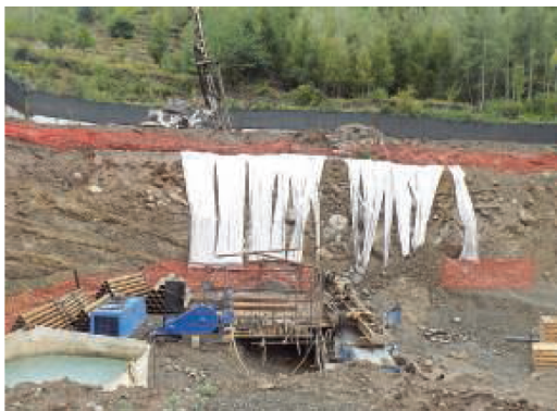
Il luogo dove sarà scavato il tunnel geognostico della Maddalena
