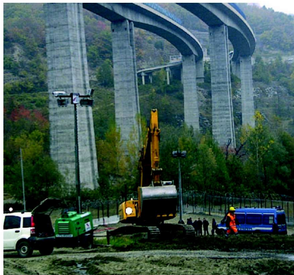
LAVORI IN CORSO Si prepara la zona per lo scavo del tunnel
