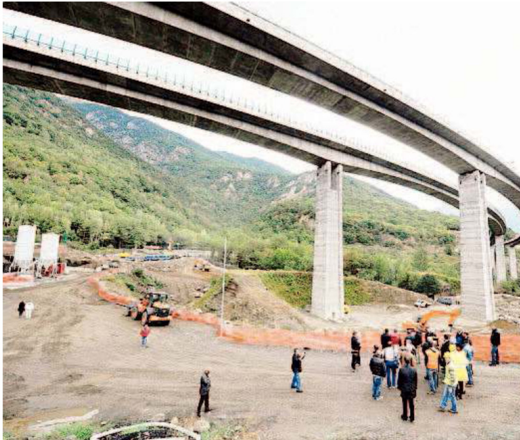
Il cantiere di Chiomonte
