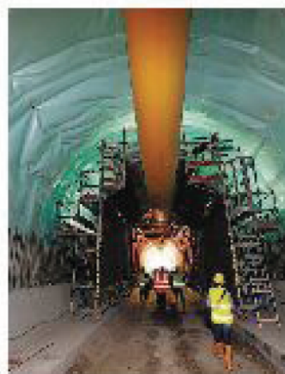
Il tunnel di Chiomonte
