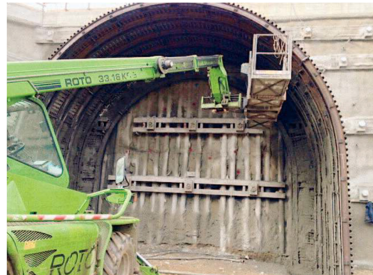
Il primo foro per il tunnel della Tav a Chiomonte
