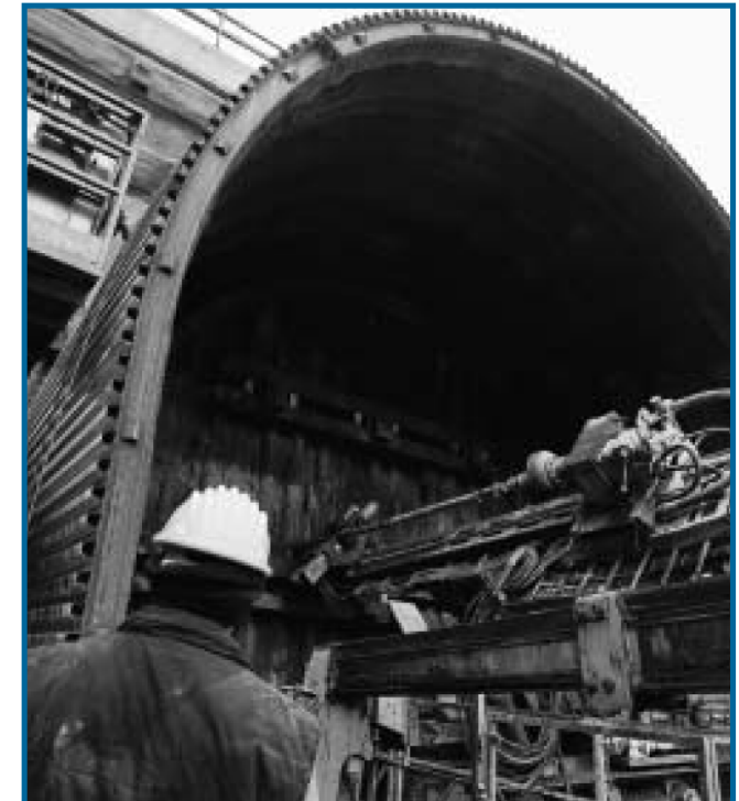
L'inizio dello scavo per il tunnel alla Maddalena
