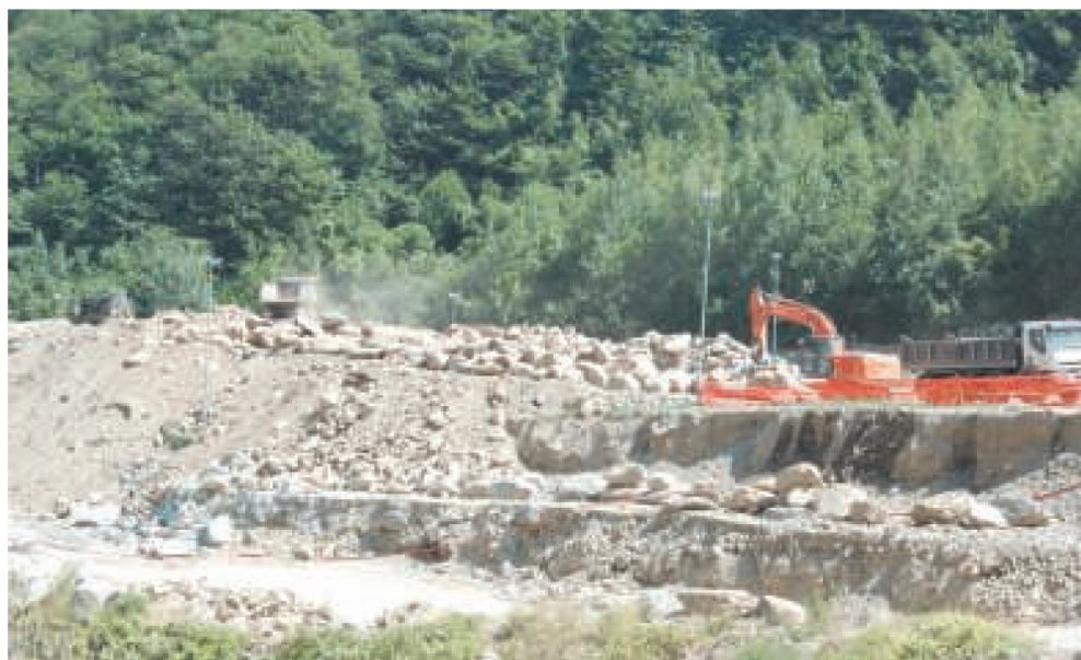
Il cantiere della Maddalena a Chiomonte (foto Giovannella)
