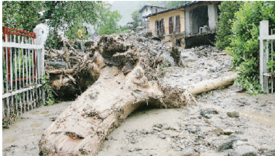
Una delle case danneggiate dall'alluvione del 2008, costata 4 vite in Val Pellice
