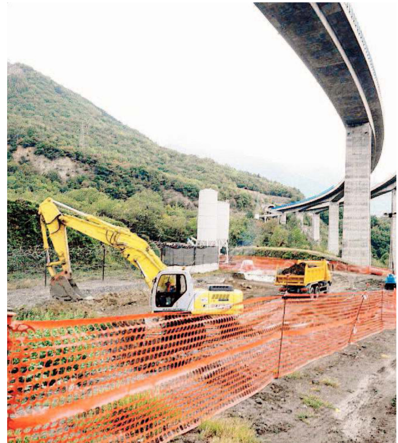
Il cantiere di Chiomonte
