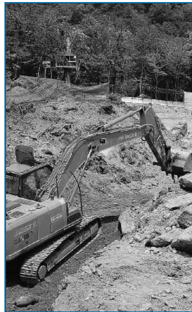
Il cantiere di Chiomonte sarà visitato dal ministro Cancellieri
