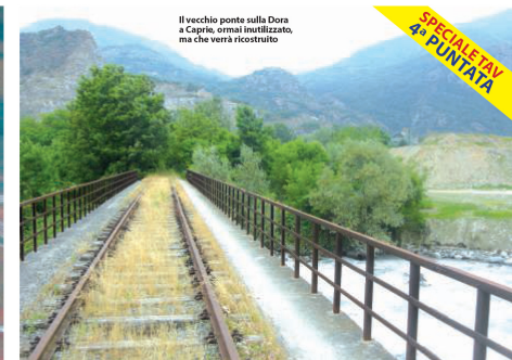
Il vecchio ponte sulla Dora a Caprie, ormai inutilizzato, ma che verrà ricostruito
