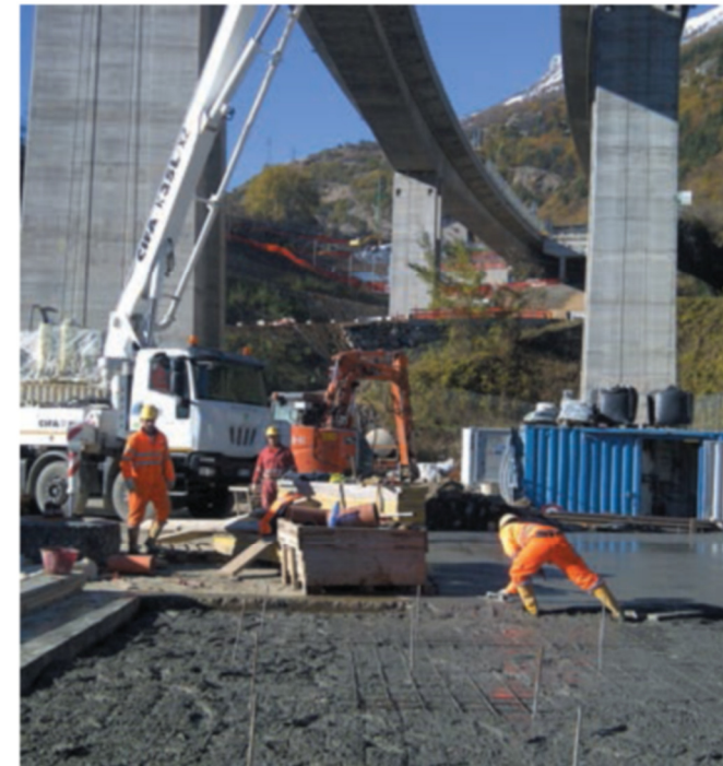
ALLA MADDALENA Il monitoraggio al cantiere è costante
