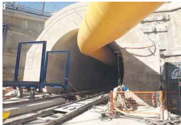
Il cantiere della Maddalena a Chiomonte
