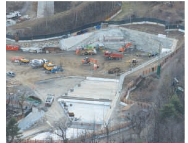
Il cantiere della Maddalena di Chiomonte (foto CR)
